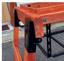
▲作業用ブラケットは、それぞれ本体側にあらかじめ付けた金折にボルト、スプリングワッシャーで固定します。
