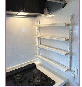
▲壁面は可能な限りネジ打ちは避けます。マグネット化粧板の場合はマグネットで固定。
